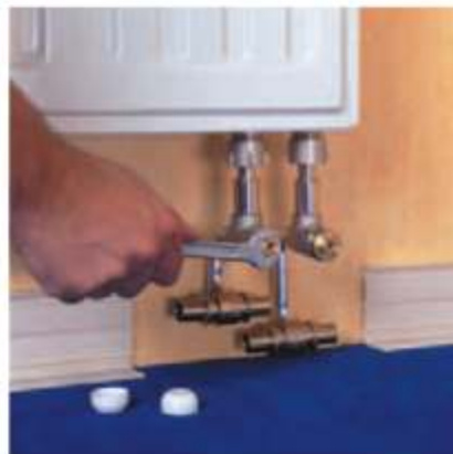
Fig. 20-30 Strângerea puternică a fittingului cu inel de strângere
