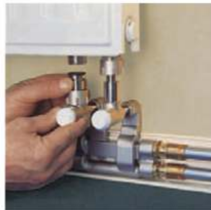
Fig. 20-11 Racord set fittinguri de colț Telescop REHAU
