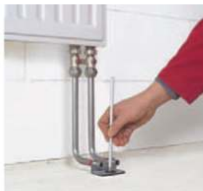
Fig. 17-4 Marcarea punctului de fixare
