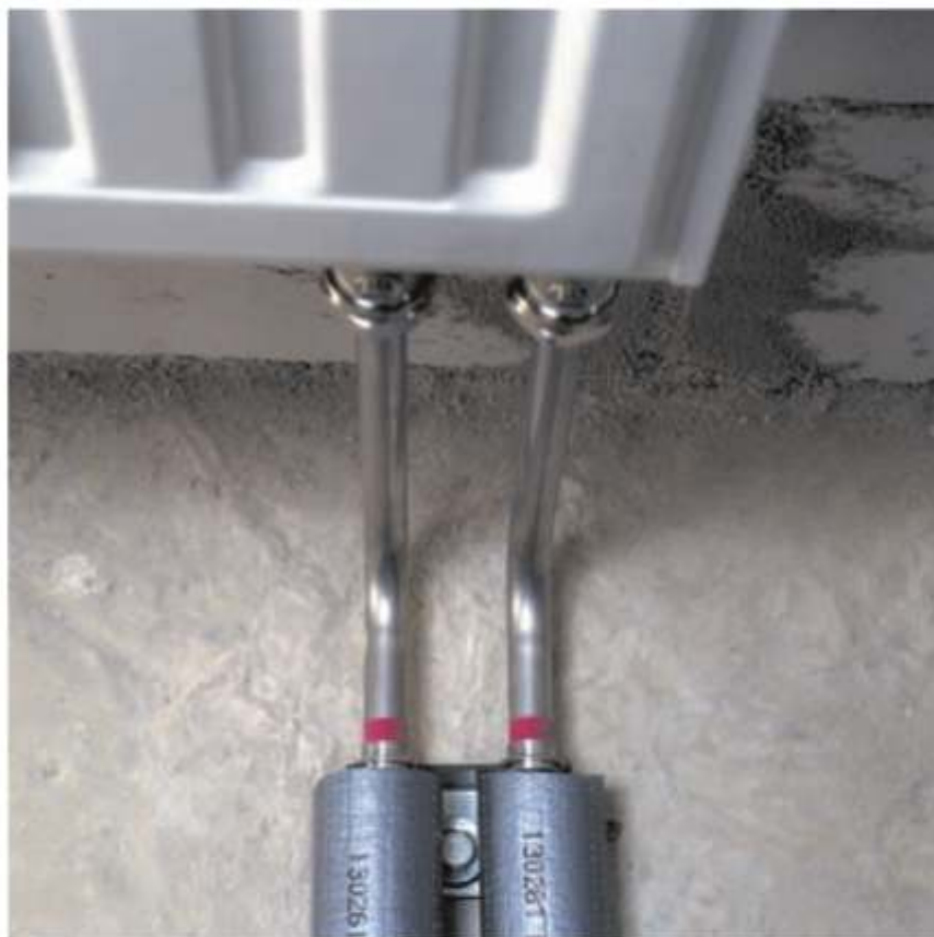
Fig. 10-1 Instalație de încălzire cu sistemul de instalații interioare RAUTITAN
