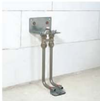
Fig. 19-3 Șablon de montaj REHAU, racord din pardoseală (exemplu de montaj)
