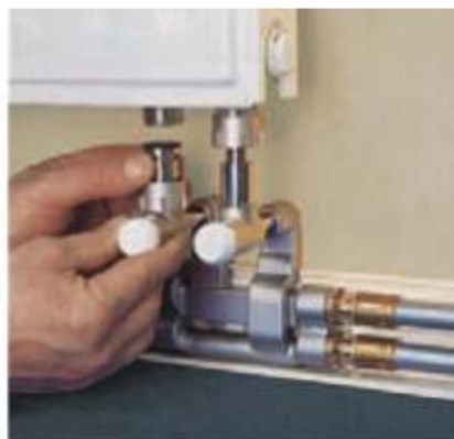
Fig. 20-23 Racordarea setului de fittinguri pentru colț Telescop REHAU la corpurile de încălzit cu ventil
