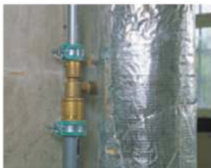
Fig. 27-1 Punctul fix executat cu brățări de fixare a țevii
