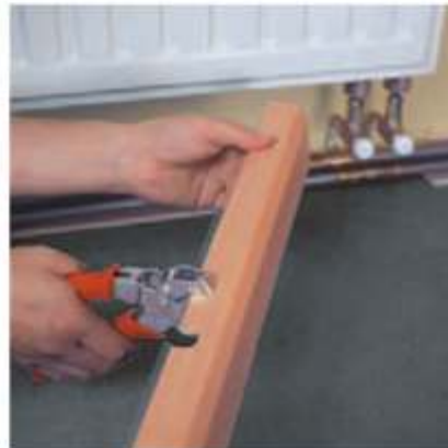
Fig. 20-31 Decuparea părții superioare a canalului plintei
