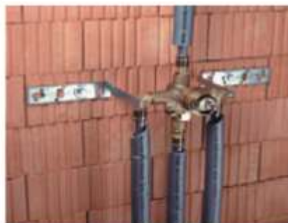
Fig. 3-7 Exemplu racordare armături cu RAUTITAN
