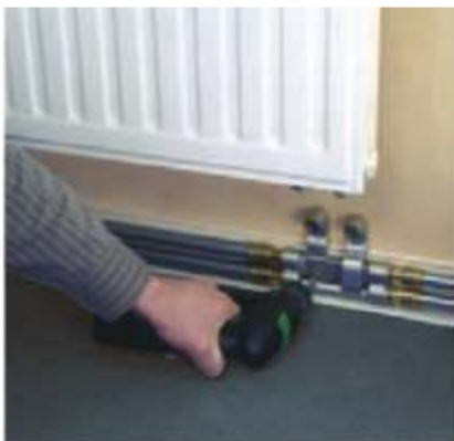
Fig. 20-21 Fixarea fittingului de încrucișare SL RAUTITAN
