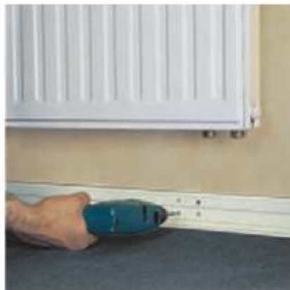
Fig. 20-17 Fixarea părții inferioare a canalului plintei REHAU RAUSOLO
