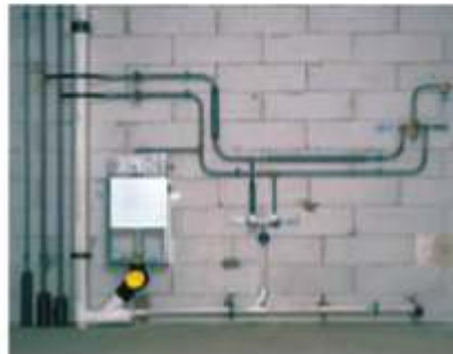
Fig. 3-6 Instalație de apă potabilă cu RAUTITAN
