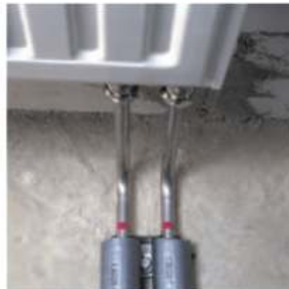
Fig. 3-8 Racordarea corpurilor de încălzit cu RAUTITAN
