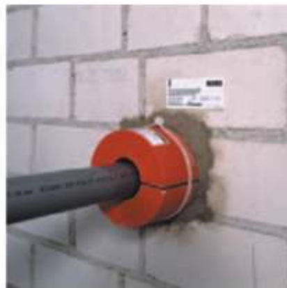
Fig. 3-13 Manșetă anti-foc REHAU Sistem RAU-VPE
