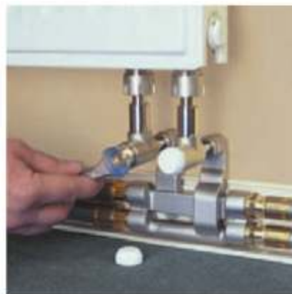
Fig. 20-24 Strângerea tare a fittingului cu inel de strângere
