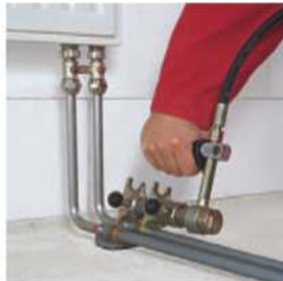
Fig. 17-6 Realizarea îmbinării manșonului alunecător
