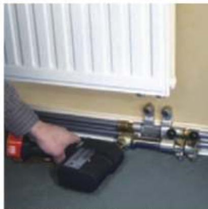
Fig. 20-19 Îmbinarea manșoanelor alunecătoare, dimensiune 16 la fittingul de încrucișare SL RAUTITAN
