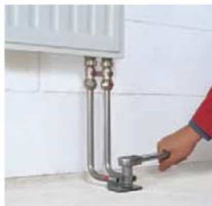
Fig. 17-5 Înșurubarea fermă a unității de fixare
