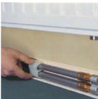
Fig. 20-22 Introducerea cu clichet a suportului țevii de încălzire REHAU
