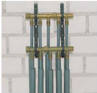
Fig. 19-10 Distribuitorul manșonului alunecător REHAU
