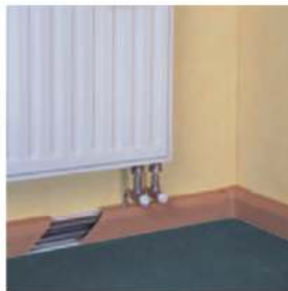
Fig. 20-32 Canalul plintei REHAU RAUSOLO gata montat cu tija de racord SL RAUTITAN
