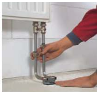
Fig. 17-3 Fixare tijă de racord în „L” a corpului de încălzit
